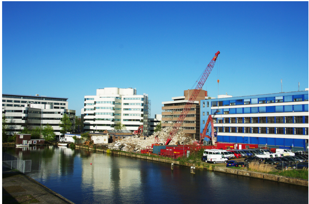
Afbeelding 14. De landtong tijdens de sloop van de oude gebouwen, dus vóór het booronderzoek.
